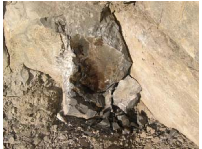
Photo 4 : Localité d'Ait Moussa dans le Moyen Atlas (Maroc) montrant du bitume en remplissage des fractures tardives.
