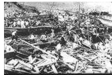
Figure 3 : Dommages causés par un Tsunami
