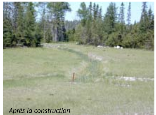
Figure 3. Installation d'un système de traitement passif (drain anoxique calcaire) au site de l'ancienne mine Lorraine, Témiscamingue. Gauche : Pendant la construction, Droite : Après.
