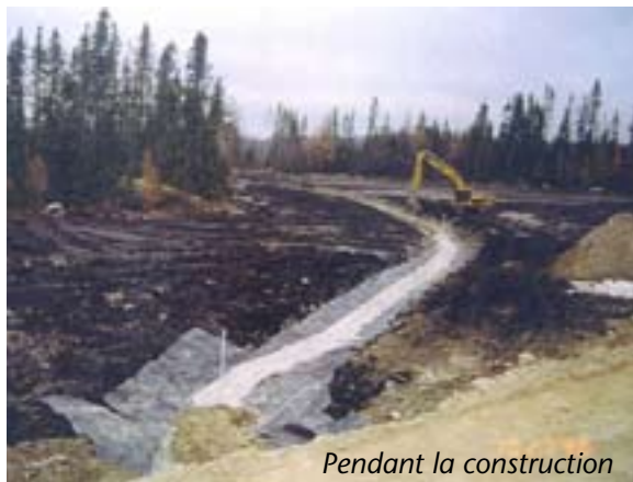
Figure 3. Installation d'un système de traitement passif (drain anoxique calcaire) au site de l'ancienne mine Lorraine, Témiscamingue. Gauche : Pendant la construction, Droite : Après.
